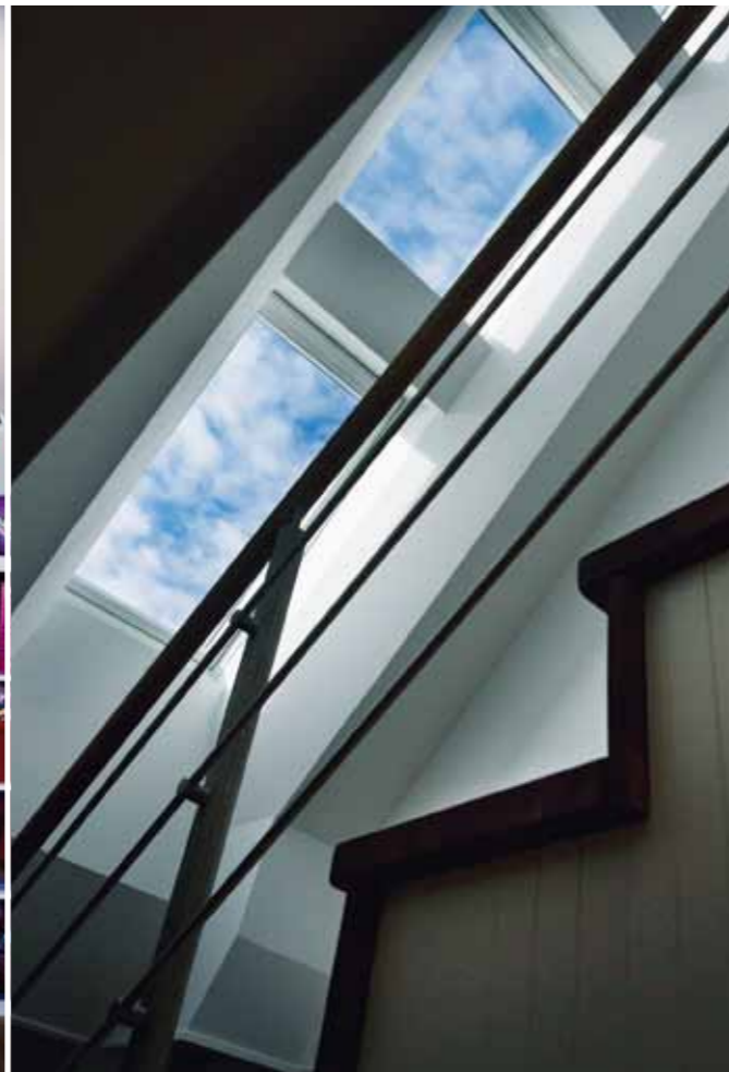
SVALKANDE. Sommartid blir huset varmt trots att inga fönster har söderläge. Takfönstren över trappan släpper in sval luft.
