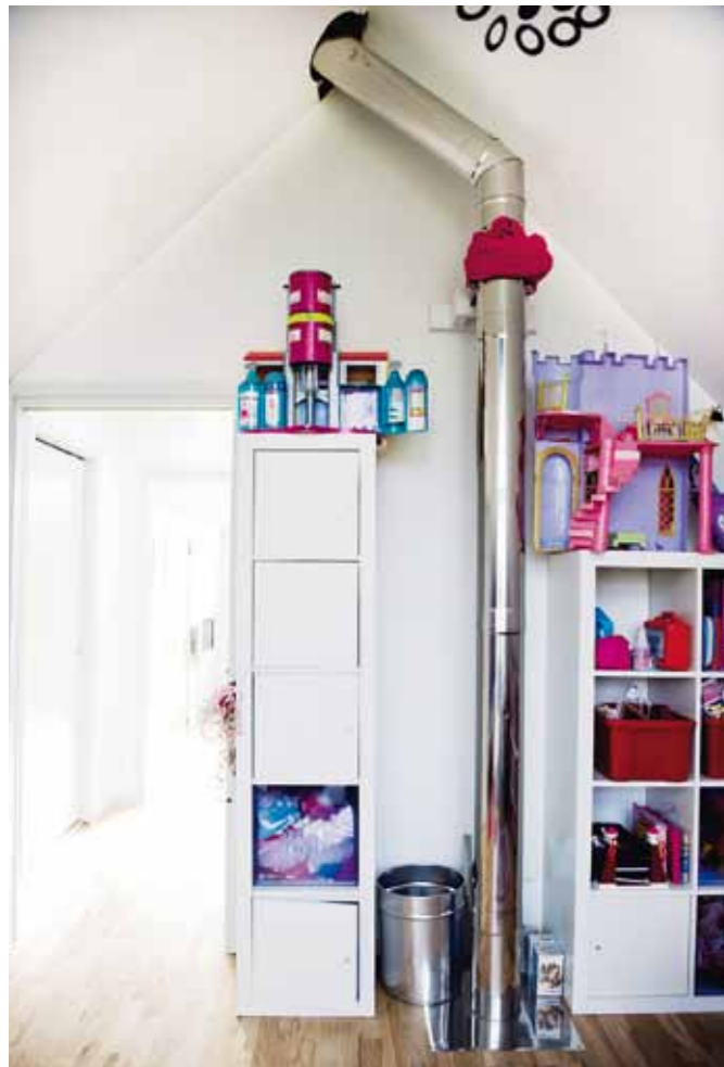
OTÄTT. Den rostfria skorstenen från kaminen passerar genom dottern Mikaelas sovrum. Ett av de få byggfelen i huset var ett läckage vid skorstenen som har tätats. Nu ska innertaket lagas.
