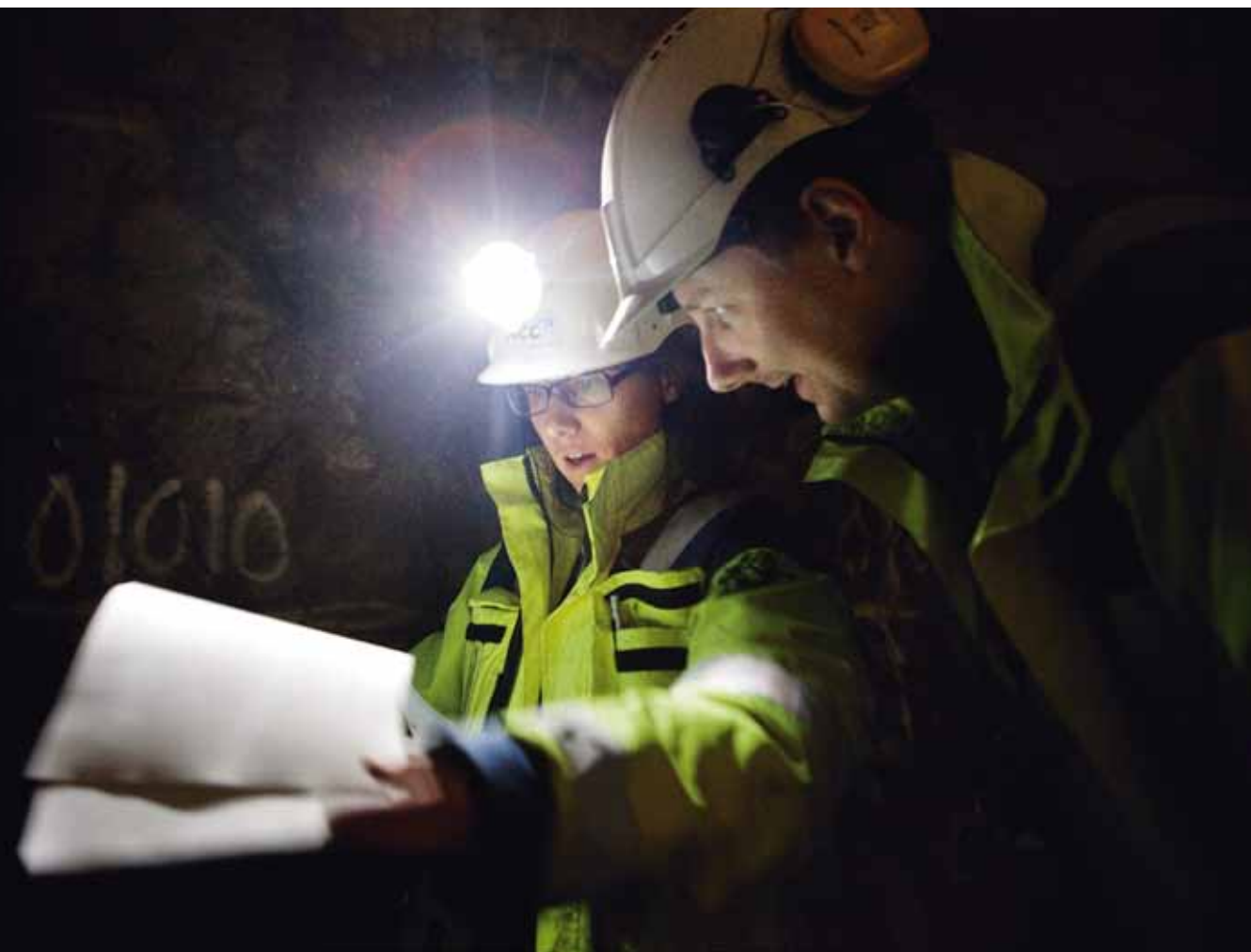
BERGSÄKERT. Cecilia Montelius, geolog, och Fredrik Ahlgren, arbetsledare på NCC, diskuterar bergförstärkning. Berget i tunnarna förstärks genom att man borrar och gjuter fast bergbultar.
