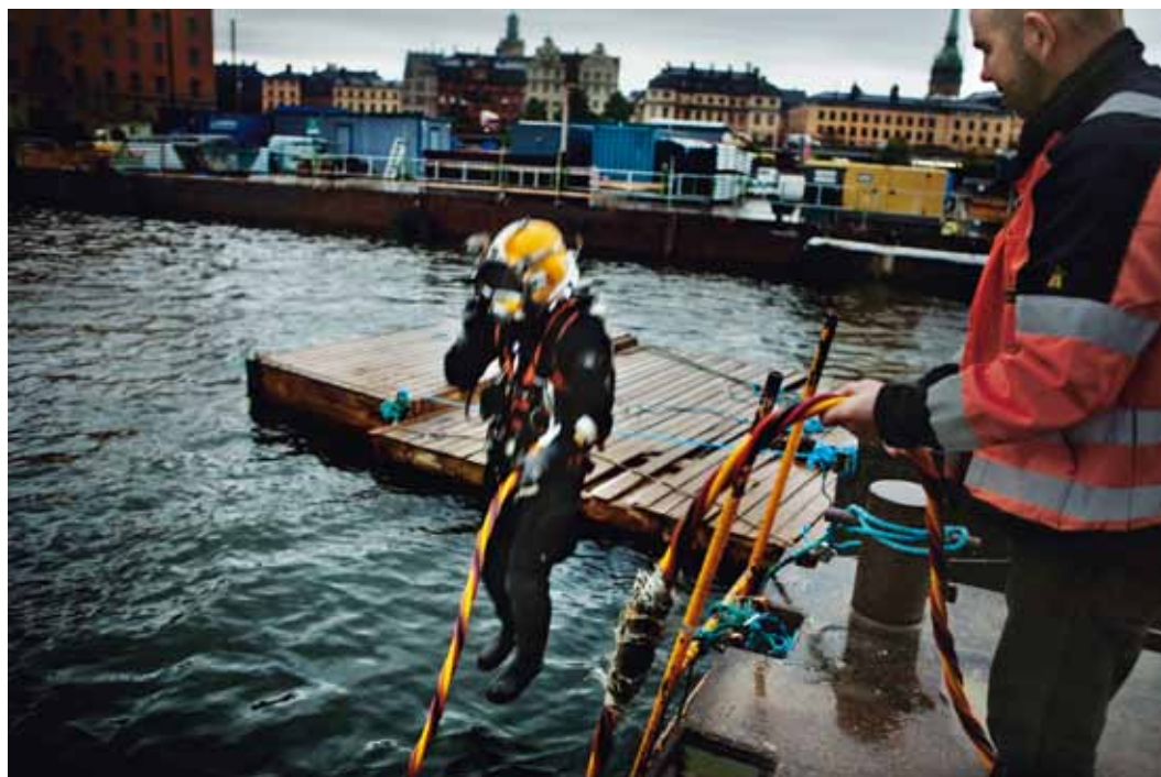
DYKJOB . Dykaren Ross McNally är på väg ner för att kontrollera ett av tunnelstöden i Söderström på 21 meters djup. Vattnet är grumligt och sikten är normalt inte mer än en halvmeter.
