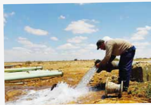
26 APRIL. Vi erbjuder kommunen att reparera gamla vattenbrunnar. Här har vi fått igång en av brunnarna.
