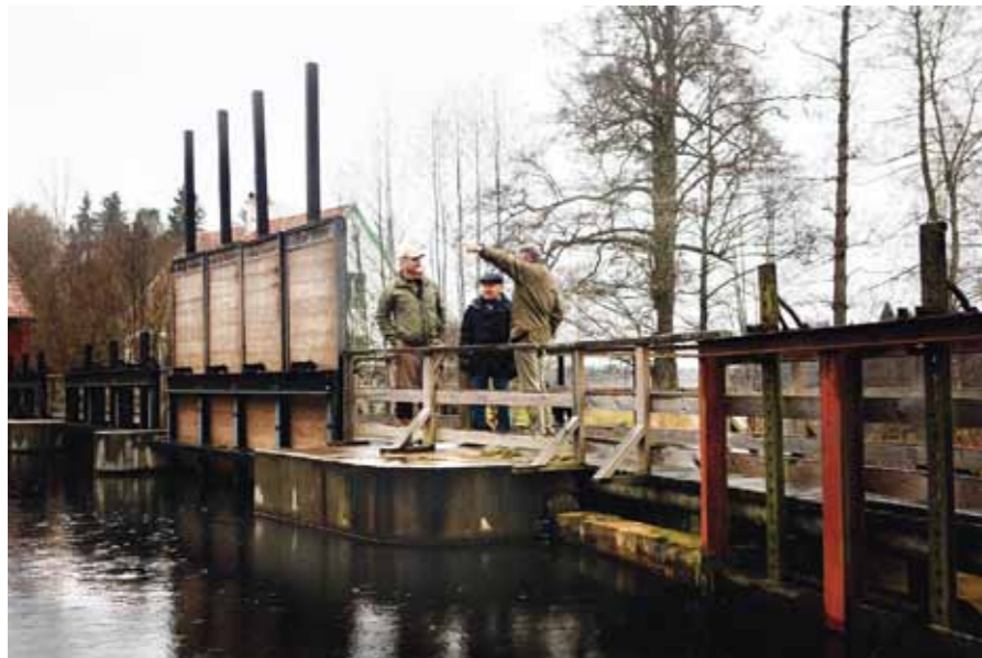
NYGAMMAL. Vattenkraftverket har dammluckor av trä, precis som föregångaren i början av 1900-talet.
